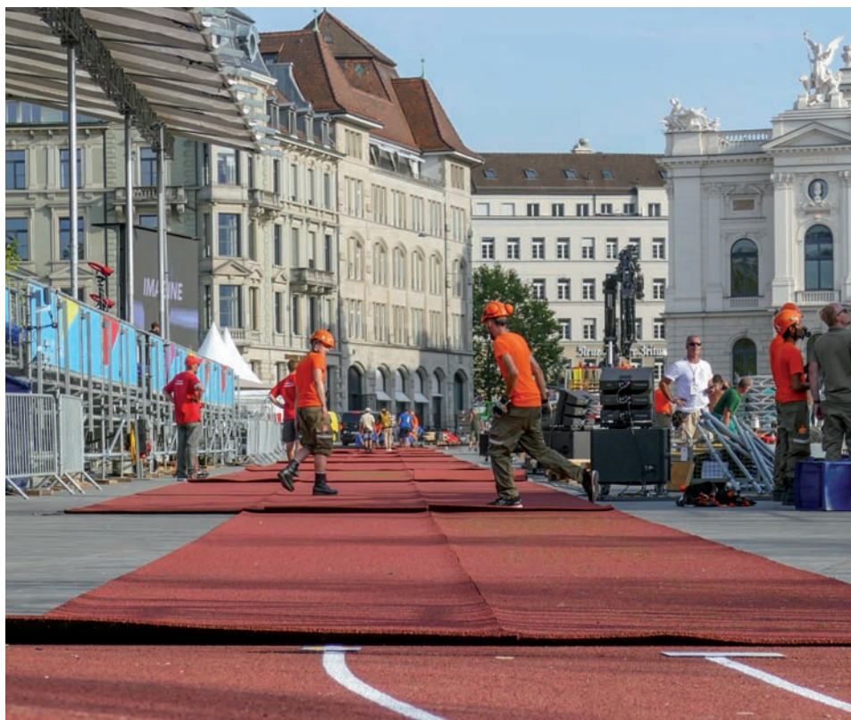
VERLEGUNG DER TARTANBAHN UM DEN SECHSELÄUTENPLATZ UND DAS OPERNHAUS.
