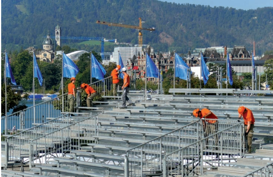
TRIBÜNENAUFBAU AUF DEM SECHSELÄUTENPLATZ UND DAS MIT AUSSICHT.
