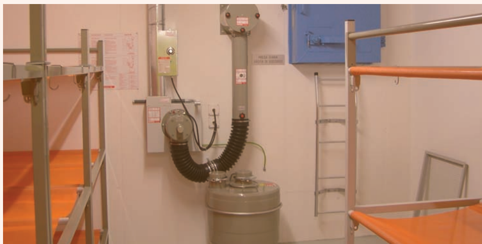
DIE SCHUTZRAUMBAUPFLICHT BLEIBT BESTEHEN, DER BAU WIRD ABER DEUTLICH GEDROSSELT.
