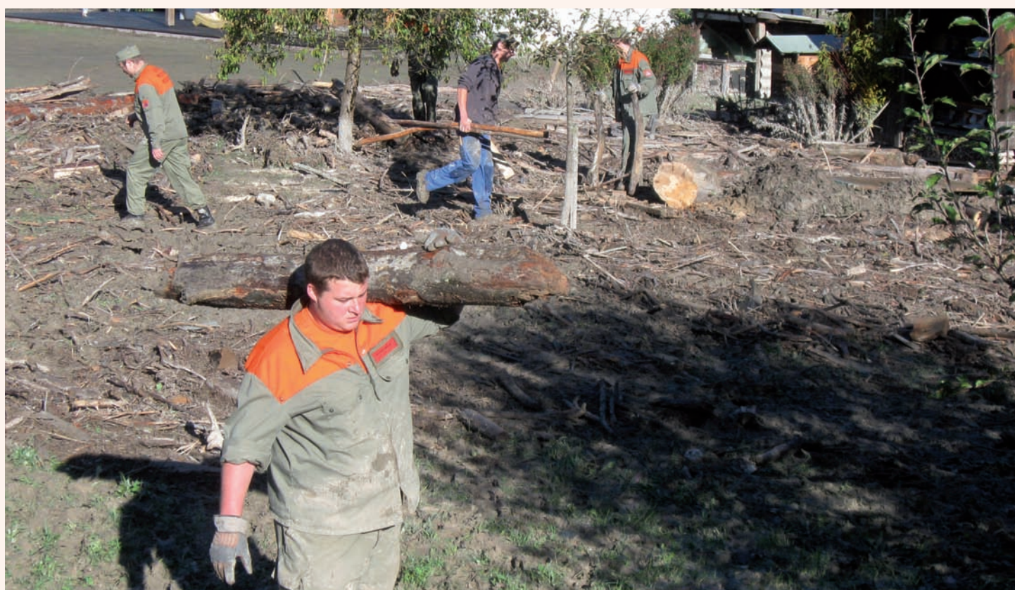
LAVORI DI SGOMBERO A FRUTIGEN DOPO L'ALLUVIONE
