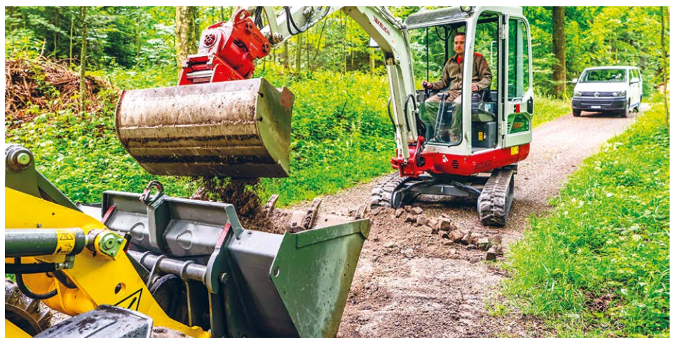
Im Riffigwald nahmen Spezialisten der Kompanie Pionier Sanierungsarbeiten vor.
